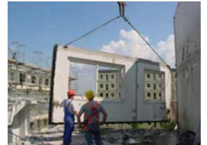
Rückbau großformatiger Bauelemente im Wohnungsbau - nicht nur eine technische Herausforderung
