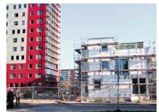
Umbau eines Hochhauses zu Stadtvillen in Cottbus.
