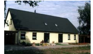
Doppelhaus: bereits 1999 wurde in Eggesin unter Wiederverwendung von gebrauchten Platten ein Neubau realisiert
