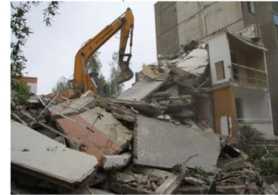
Bei der Gewinnung 1 t Betonbruch aus dem Abbruch fallen ca. 0,187 t verschiedener anderer Abbruchmaterialien an. Die gesamte abzubrechende Menge beträgt somit 1,187 t pro 1 t.
