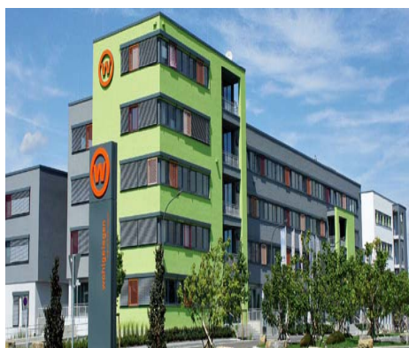
Abb. 2: Heilbronn / Büro- und Lagergebäude
